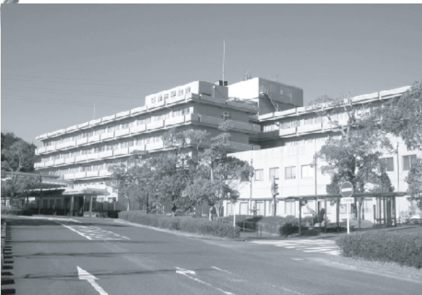
↑利活用が求められる現袋井病院。
