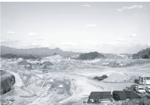
↑造成工事が進む掛川・袋井新病院。
