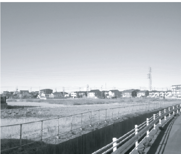
↑近く工事が行われる中央部保育所の建設予定地。
