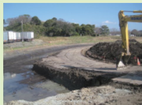
久野城南遊水地の掘削工事
