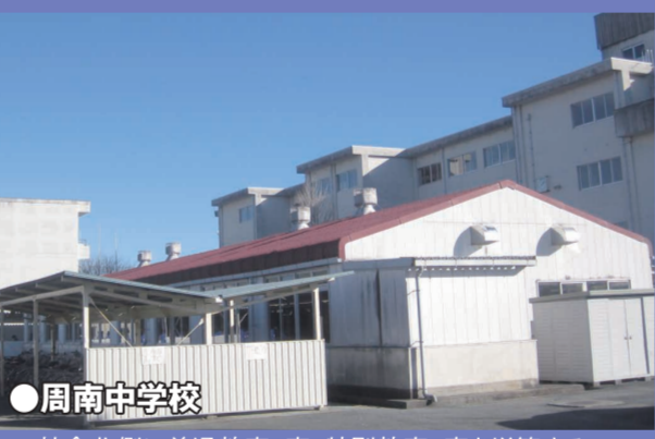
●袋井北小学校 校舎の北側に延長し普通教室6教室を増築する
