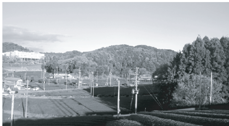
▲造成工事が始まる豊沢地区開発
