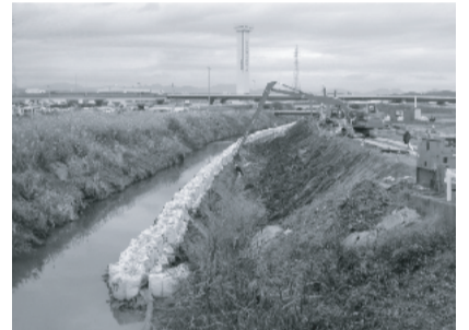
沖之川で始まった河道拡幅工事
