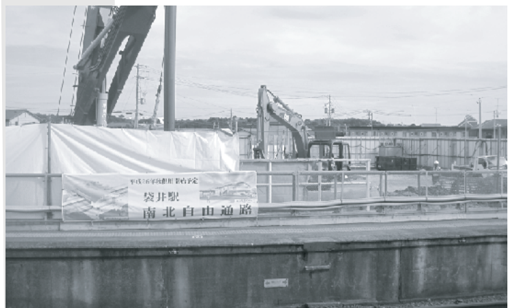
▲来年完成する新袋井駅舎。
