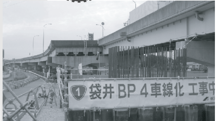
▲進む国道1号線の4車線化。
